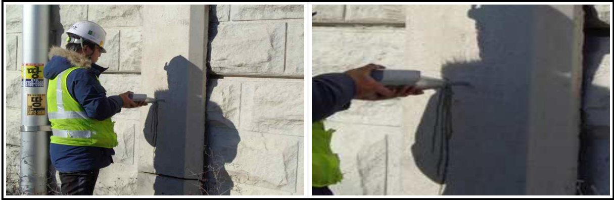
【그림 7.3.6】 슈미트해머를 이용한 반발경도시험 전경
